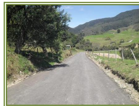
Vía estabilizada químicamente con carpeta de rodadura. Tramo de la pista de prueba Entrerrios – Labores – San José de la Montaña.
