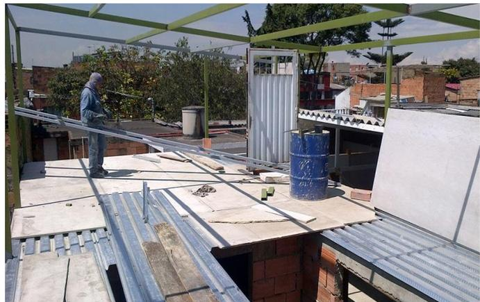
**Entrepiso en seco con lámina de fibrocemento desmontable**
