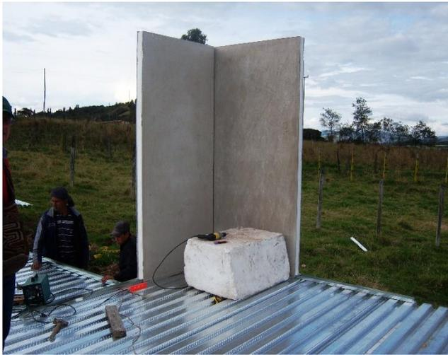
**Instalación de Paneles CECO sobre Losa Metálica**
