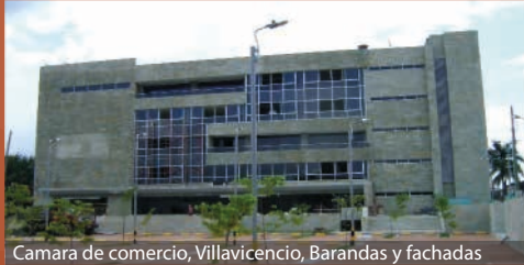
Camara de comercio, Villavicencio, Barandas y fachadas
